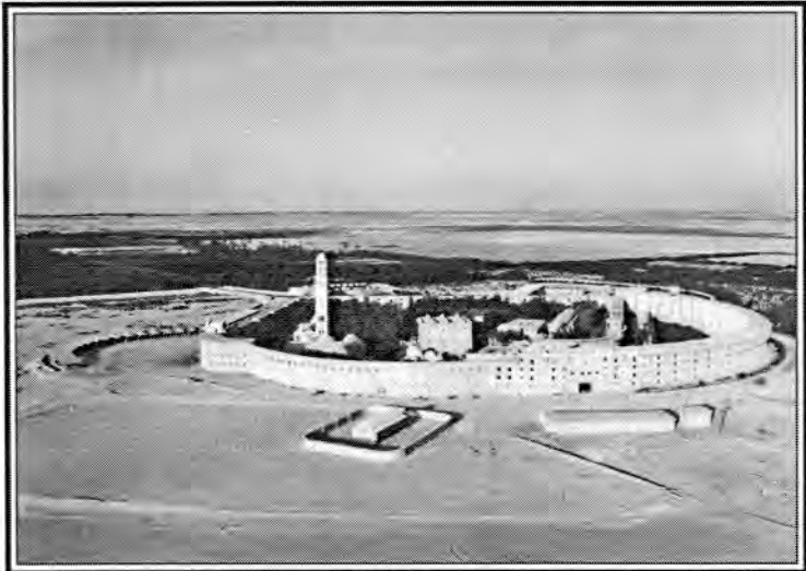
Le monastère de St-Macaire, après sa reconstruction
